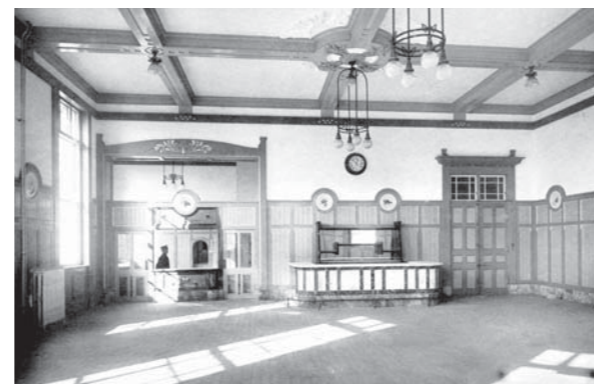
1階食堂 『記念写真帖 大正三年十二月』1914年(大正3) 1階の南端部にあった。正面は大理石造のカウンターがあるバー。調理場は地下に設けられていた。
