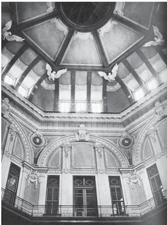
乗車口(南側)ドーム内部の吹抜け 『記念写真帖 大正三年十二月』1914年(大正3) 鳥・兜・剣・干支などのモチーフが用いられた華麗な装飾が施されている。中心部の天井高は91尺。
