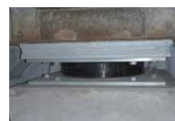
免震アイソレーター Seismic isolator
