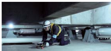
僅か70cmほどの厳しい作業環境のもと免震化が行われました Seismic base isolation work carried out in a daunting work environment only 70 cm (27.6 in) wide
