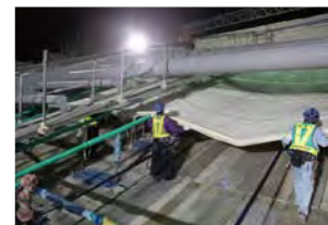
膜工事：膜を少しずつ広げていく
