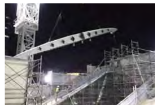
鉄骨建方：タワークレーンを用いて、大梁を架設
