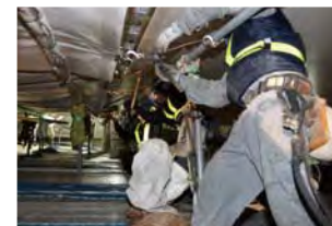
膜工事：人力で膜にテンションをかけていく
