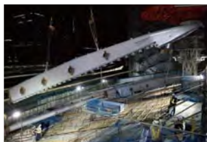
鉄骨建方：精度管理には3次元測量を採用
