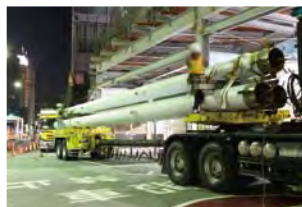
鉄骨搬入：柱を分割して搬入し、現場溶接で1本の柱を構築
