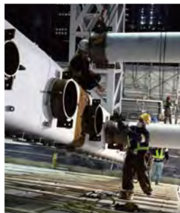
鉄骨建方：大梁に長手方向の連続梁を取り付ける
