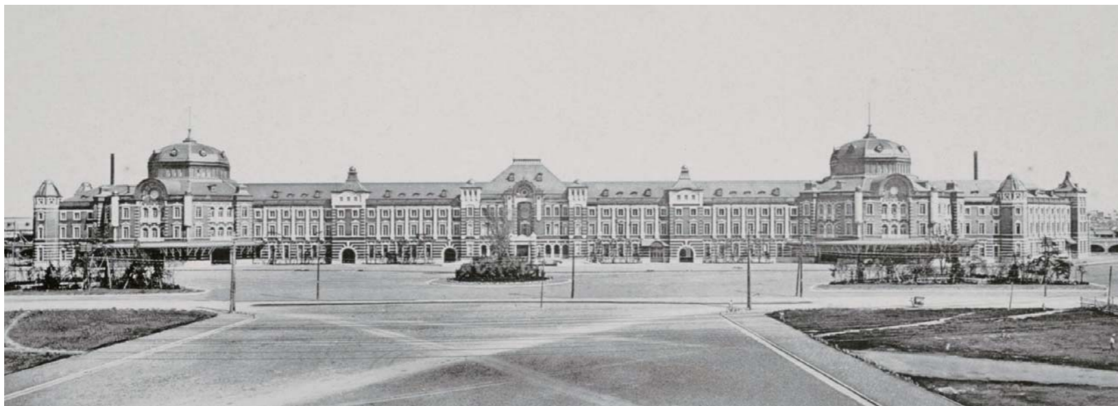
完成まもない丸の内駅舎の全景 「紀年写真帖 大正三年一二月」1914年(大正3) Tokyo Station Building just after its completion "Commemorative Photo Album: December 1914" (1914)
